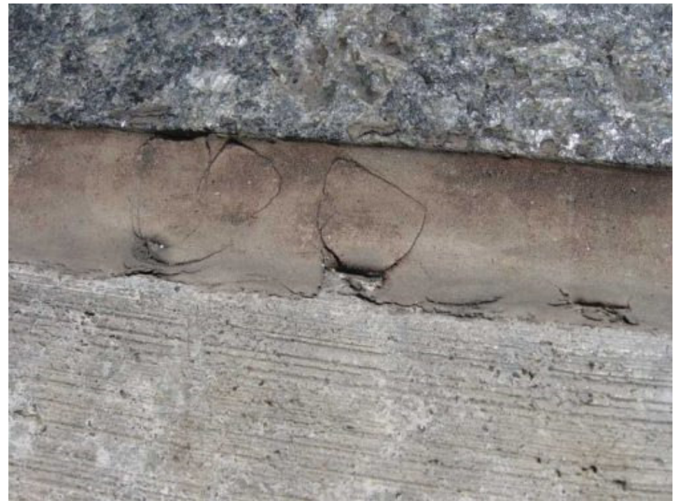
Heel Damage
